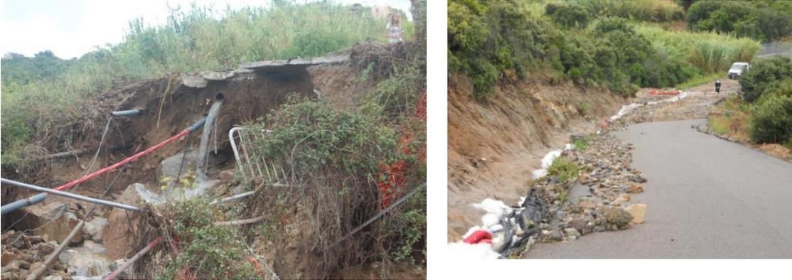
La foto in alto a sx mostra il collasso di un rilevato stradale, interessato da sottoservizi idrici, fognari, elettrici, con tombotto di sezione insufficiente a smaltire la portata idraulica determinata da un evento meteorico sensibile (sempre settembre 2012 in Gallura).
