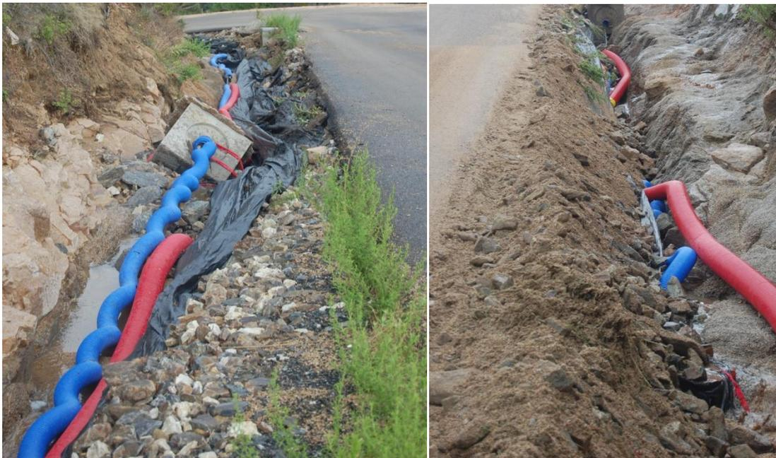
Le foto rappresentano il risultato dell'erosione e trasporto della corrente idraulica lungo una carreggiata in corrispondenza di evento meteorico sensibile (settembre 2013 provincia OT), sono state messe a nudo e totalmente stravolte le linee infrastrutturali lungo la viabilità.
